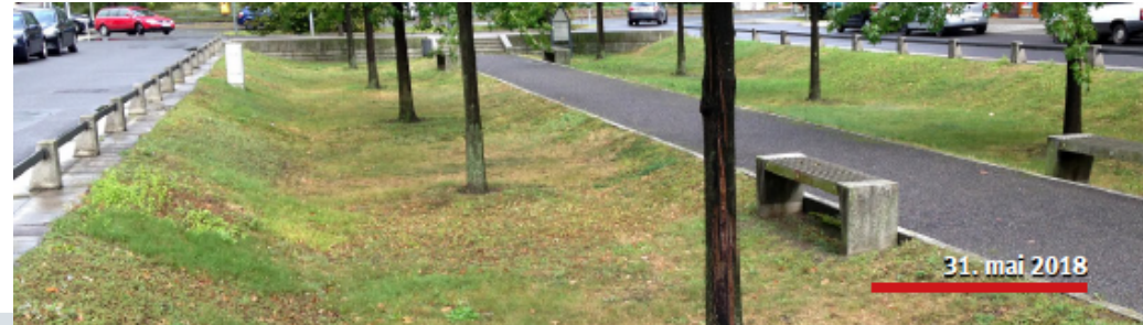
Foto: Vann- og avløpssetaten
