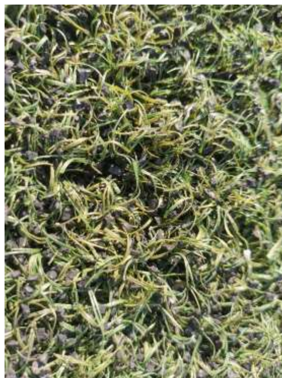
Oppsplittet fiber som har lagt seg over fyllmaterialene, Bankgata Kunstgressbane
